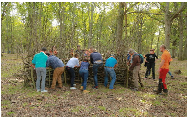
Construction d'abri pour la faune
